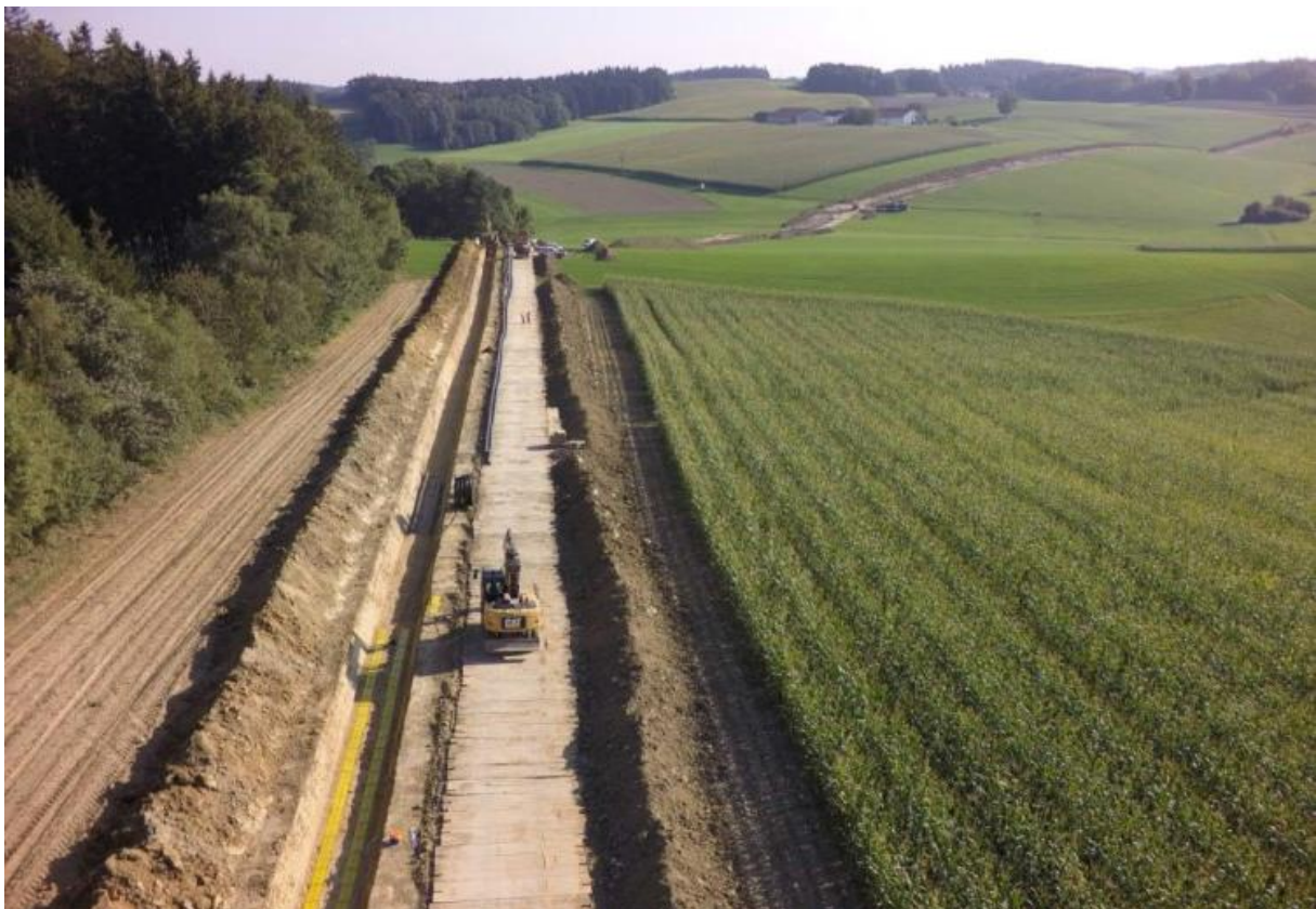
Abbildung 2: Kabelverlegung in offener Bauweise
